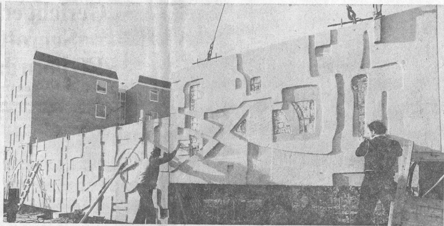
VOR DEM HINTERGRUND eines mehrstöckigen Wohnhauses wurde gestern am Hausbäcker Weg bei der Tonkuhle Eversten eine 20 Meter lange und zweieinhalb Meter hohe Beton-Reliefwand mit Glas-Kupfer-Mosaiken aufgestellt. Die in vier Teilen von je sieben Tonnen Gewicht angelieferte Wand soll einen
